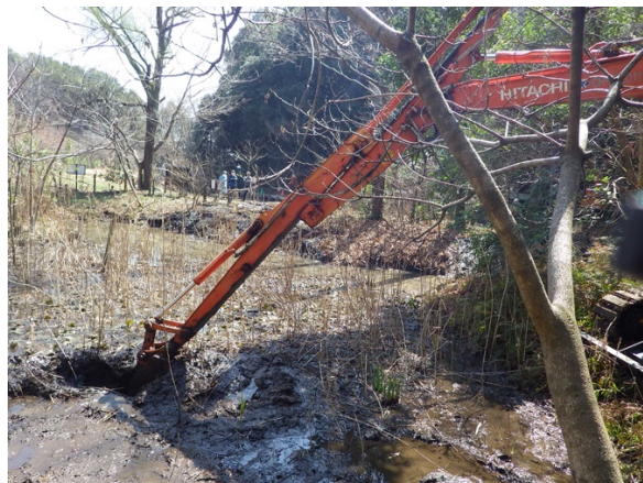
重機が入って観察池の泥、ヨシの根、睡蓮の根を掘り出しました
